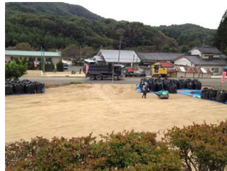
写真2 山砂で置換された農地の表土
